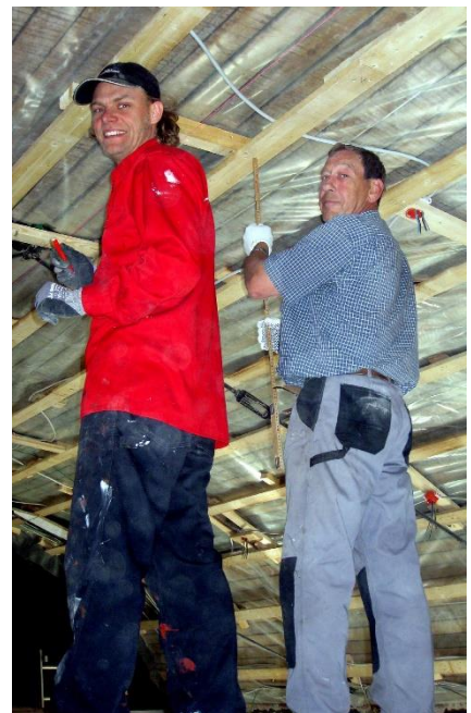
Anders Klogh (t.v.) og Verner Sørensen i gang med det nye loft på tøndehvælvingen.
